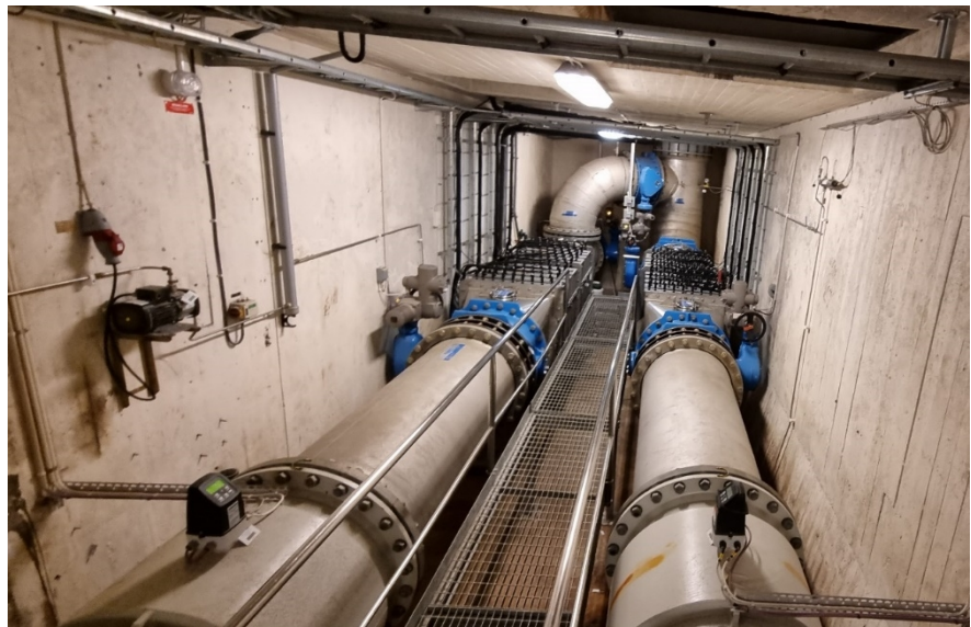
Bild 1 – UV-aggregaten i befintlig miljö
